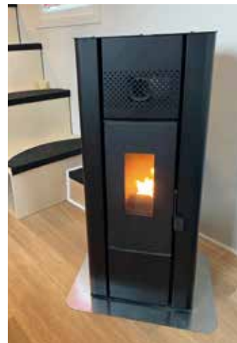
Elektronisch gesteuerter Pelletofen im baugenehmigten Tiny House on Wheels. Leistungstechnisch auf das Raumvolumen im Tiny House optimiert, kann ein Pelletofen die Anforderungen der EnEV 2016 im Hinblick auf erneuerbare Energien erfüllen.
