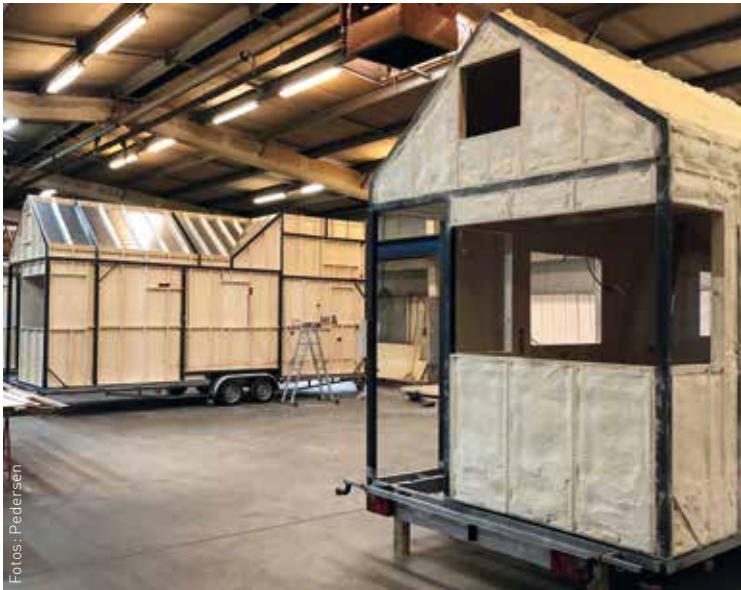
Vollummanteltes Tiny House mit einer Polyurethan-Dämmung. Trotz der auf Erdöl basierenden Dämmung kann die Ökobilanz über einen Nutzungszeitraum von 40 Jahren besser als mit vergleichbaren ökologischen Dämmmaterialien sein. Im Hintergrund ein im Bau befindliches Tiny House mit einer zusätzlichen Hightech-Dämmung, bestehend aus mehrschichtiger Aluminiumfolie und Luftpolstern.
